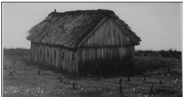
Boerderij in Oostpolder ten westen van Gouda ca 1100, groot 18 bij 11 meter, op een terpje van 40 cm hoog, houten palen met daartussen wanden van gevlochten wilgentenen en leem, stal met matten op de grond voor 8 stuks vee, varkenskot, paard, verbouwt op de natte grond emmertarwe en vlas, haardvuur midden en rook kringelt door gat in het dak, woonruimte lemen vloer, geen zolder, opgegraven in 1996.
