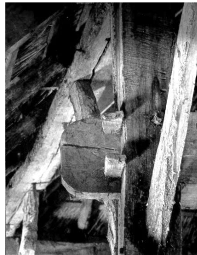
Figuur 16. Foto van ankerbalkgebinten
